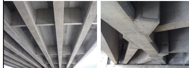
複雑な形状の橋梁の例 (T桁橋梁など)
