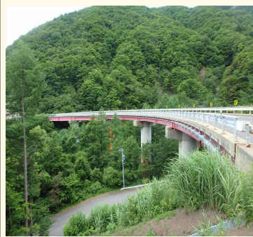
全景：終点側から起点側を望む
