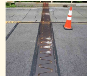
伸縮装置 (A1橋台部) 排水型
