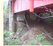
A1橋台 (調査箇所)
