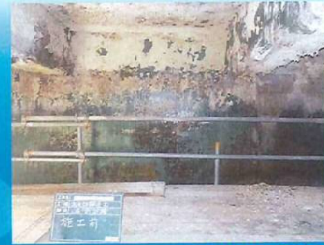
事前調査実施 中性化深さ等の調査
