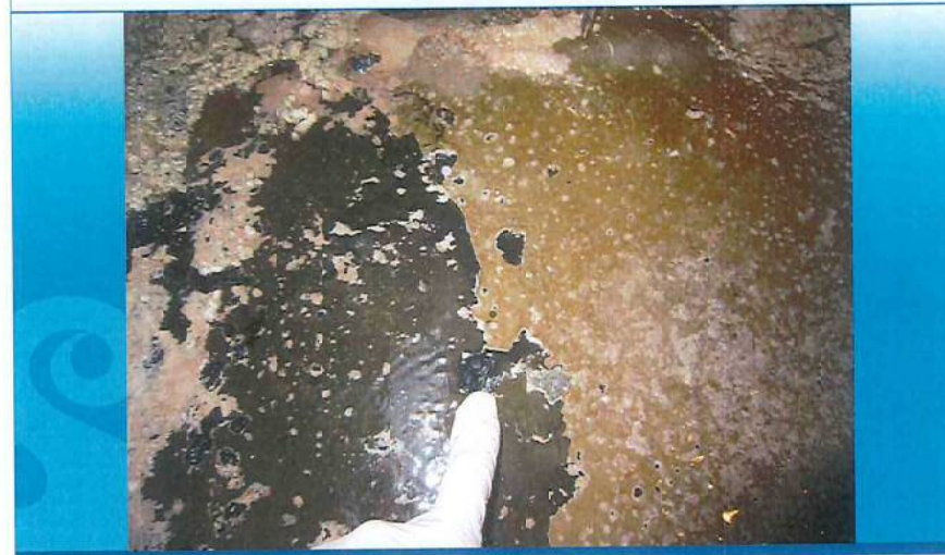
床面の塗膜劣化
