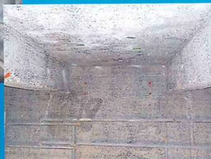
超高压洗浄後
