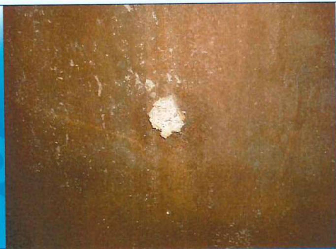
爆裂の状況 ～塗膜ピンホール由来～
