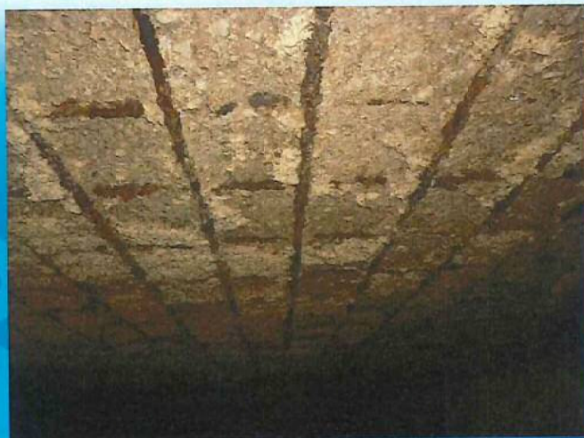
天井部鉄筋腐食状況
